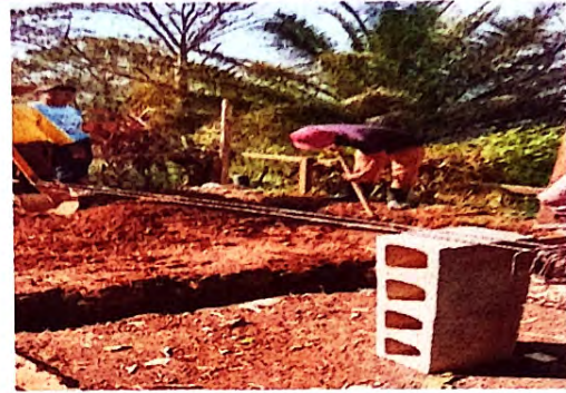
Foto 2: Remozamiento del ambiente de cocina
