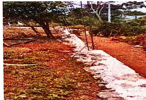
Foto 4: Colocación del cimient del muro perimetral
