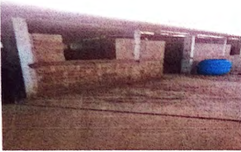
Foto 1: Remodelación de Aula
